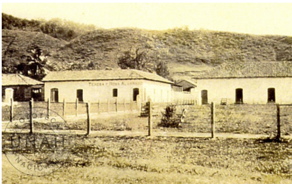
Inicios de la construcción del parque Centenario entre la primera y segunda década del siglo XX, nótese que los postes de madera ya se han establecido. (Foto: Colección Fototeca Nacional, UNAH)
