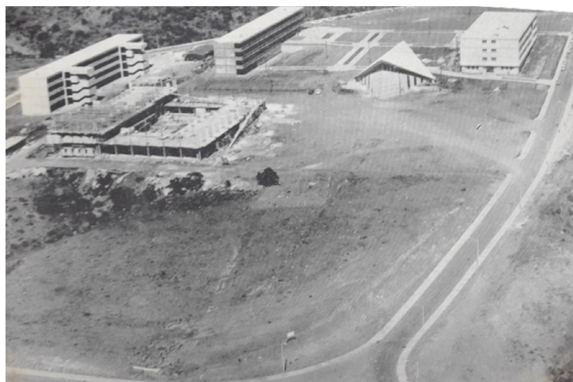
Avances constructivos en Ciudad Universitaria, vista de conjunto de Occidente a Oriente.
