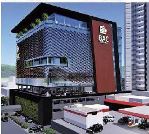
El edificio se compone de fachadas de muros cortina de cristal y perfilería de aluminio. El uso de pantallas verdes es incorporado al diseño del estacionamiento.
